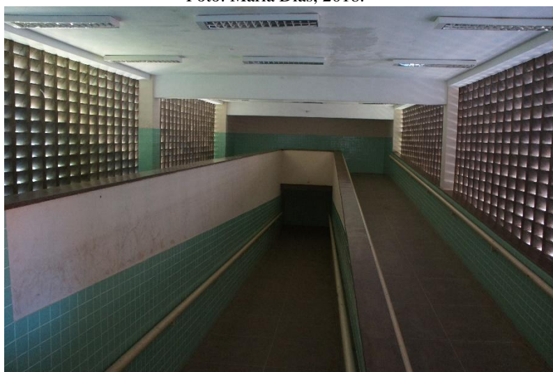
Figura 16: Rampa de acesso ao piso superior dos blocos. Foto: Maria Dias, 2018.
