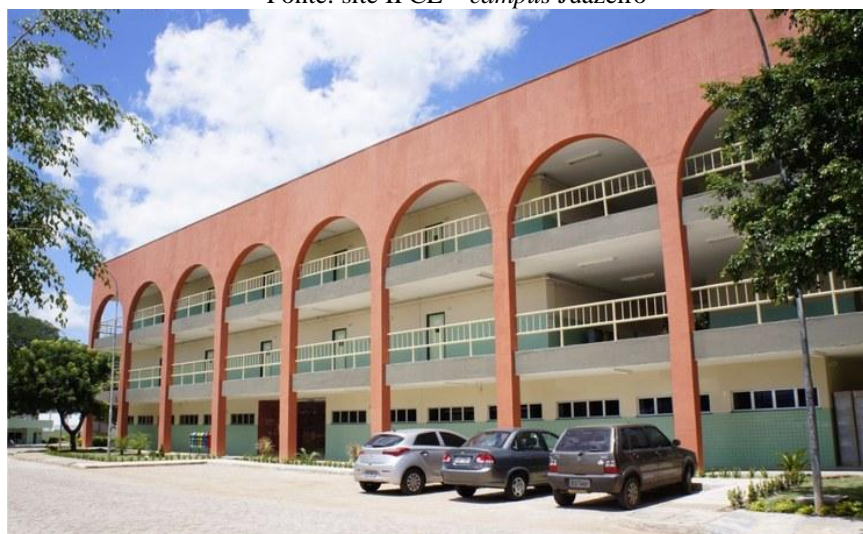
Figura 12: Bloco Administrativo e Biblioteca campus Juazeiro do Norte. Fonte: site IFCE – campus Juazeiro
