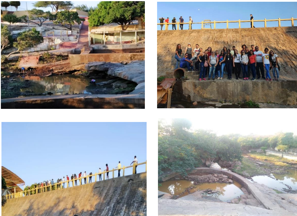
Figura 3. Vista da visita a Barragem de Carnaubal
