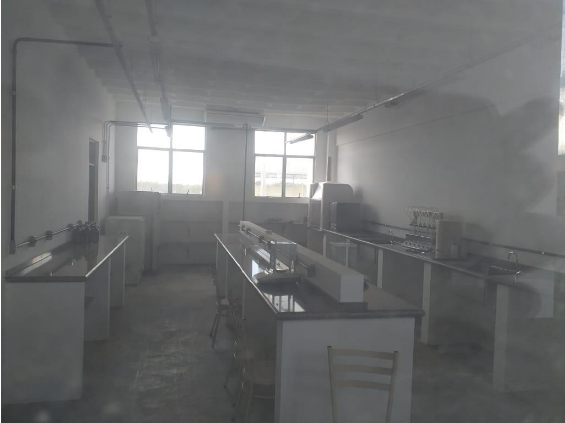
Figura 7. Construção das bancadas e das instalações elétricas e hidráulicas do laboratório de Nutrição Animal.
