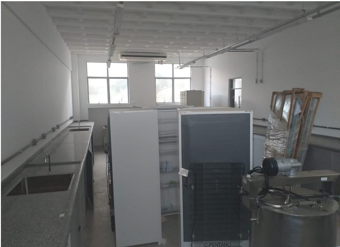
Figura 4. Construção das bancadas e das instalações elétricas e hidráulicas do laboratório de processamento de Alimentos.
