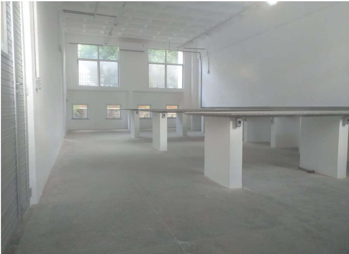
Figura 6. Construção das bancadas e das instalações elétricas e hidráulicas do laboratório de Física do Solo.
