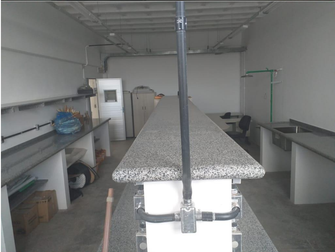
Figura 1. Construção das bancadas e das instalações elétricas e hidráulicas do laboratório de Biologia vegetal.
