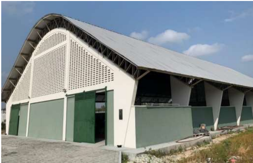
Figura 4 – Quadra Poliesportiva do IFCE Campus Paracuru.
