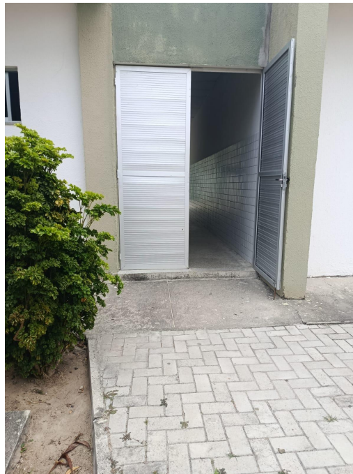
Figura 30 - Passagem para a Área de Convivência mais próxima das salas de aula
