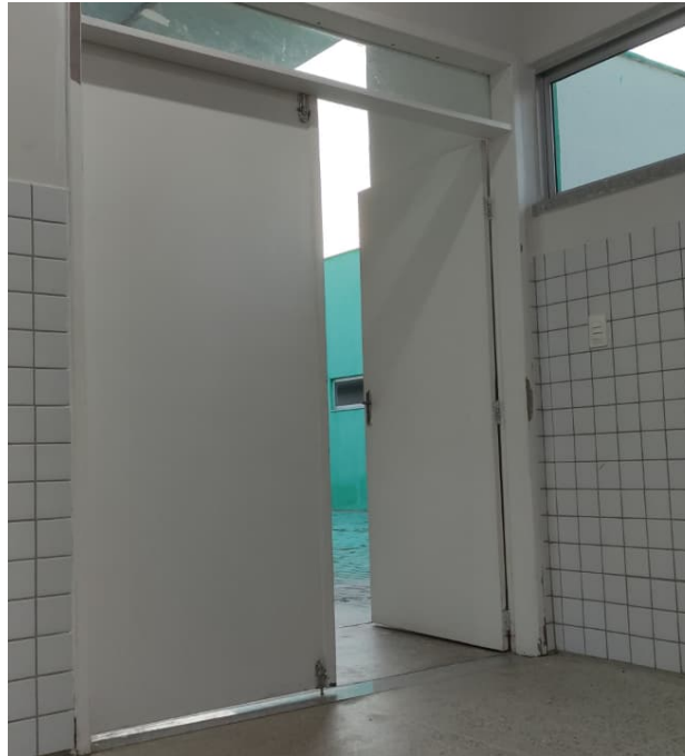
Figura 16 - Porta de acesso ao refeitório
