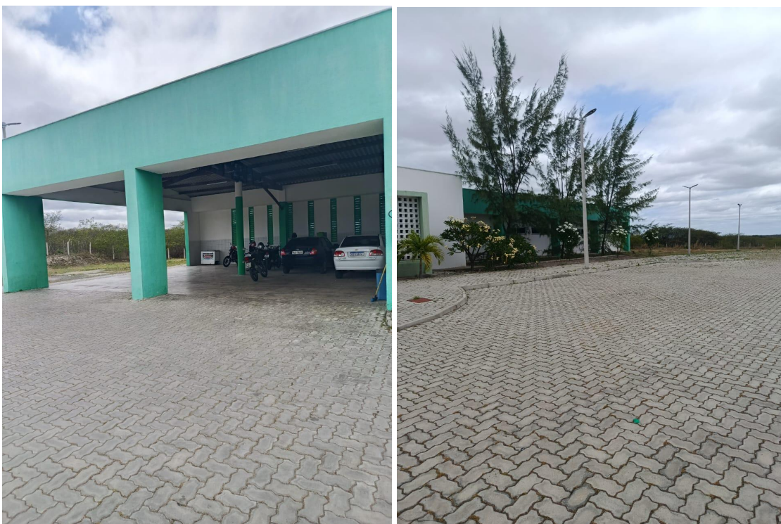
Figuras 14 e 15 - área de estacionamento
